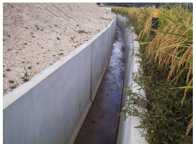
施工後 (鳥取市)
