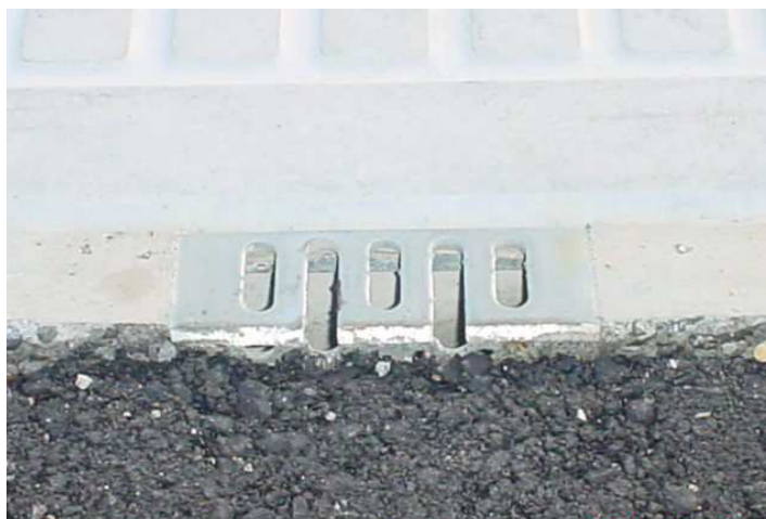
◆ 排水ドレン部 拡大 (施工後)
